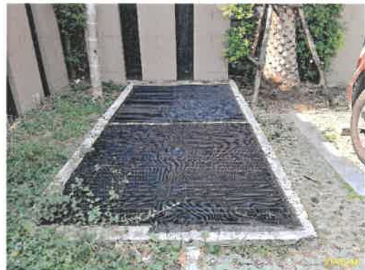
บ่อพักน้ำสุดท้ายบริเวณด้านหน้า ภาพที่ 2.2-9 ระบบระบายน้ำ
